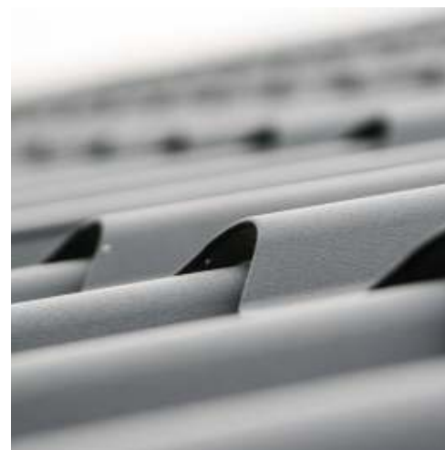
Toiture et combles
