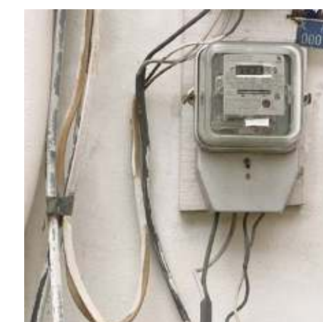
Compteurs d'électricité, eau et gaz
